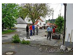
garteln am feuerwehrhaus...
